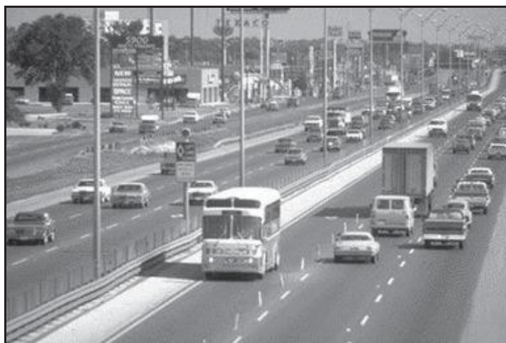
شکل شماره ۱-۳: مسیر ویژه مشترک خودروی پرسرنشین و اتوبوس در هوستون آمریکا
