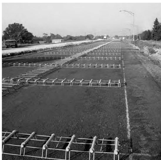
شکل ۳-۳- مجموعه سبدهای میلگردهای انتقال بار
