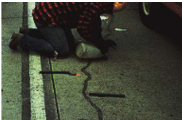
ت- ریختن اپوکسی به درون سوراخ حفر شده
