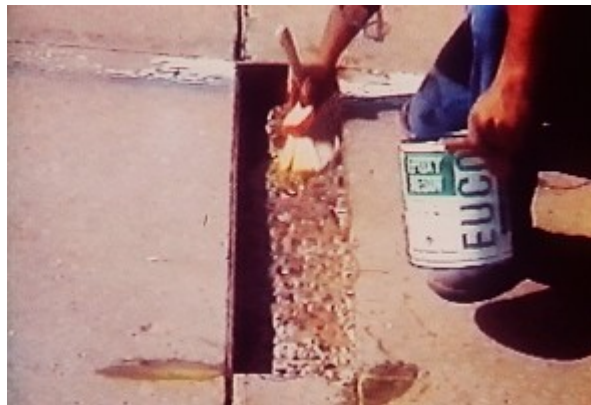
شکل ۴-۲۱- استفاده از مواد چسبنده برای بهبود اتصال بین بتن وصله با بتن زیرین
