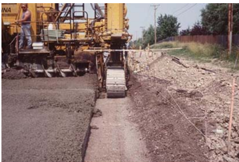
شکل ۳-۲۲- مسیر عبور تجهیزات اجرای رویه بتنی
