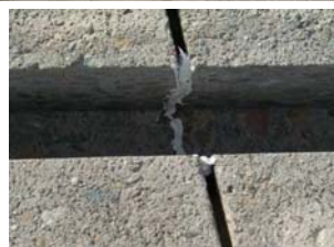
پ- بتونه‌کاری درز/ترک در محل قرارگیری میلگردهای انتقال بار
