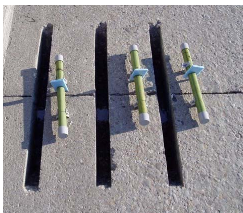
ت- قراردادن فوم بورد در وسط میلگرد انتقال بار
