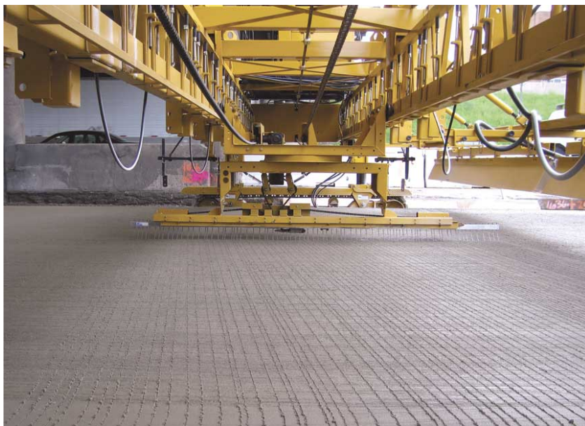
شکل ۳-۴۰- ایجاد بافت درشت (عرضی) در رویه بتنی به روش مکانیزه
