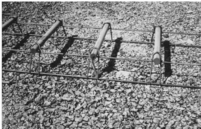
شکل ۳-۲- سبد میلگردهای انتقال بار
