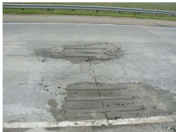
ح- اجرای سطح بتن در محل شیارها کمی بالاتر از سطح موجود
