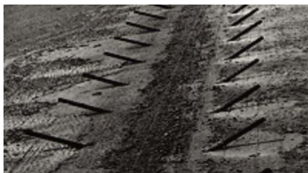
ث- قراردادن میلگردهای دوخت در سوراخ‌های حاوی اپوکسی (در این شکل میلگردها هنوز به طور کامل جای گذاری نشده‌اند)
