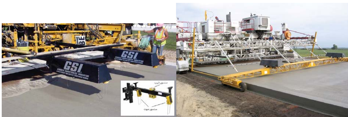
شکل ۳-۳۸- نمونه‌ای از تجهیزات دارای ابزار دقیق (سنسور) برای اطمینان از همواری سطح قبل از گیرش نهایی بتن
