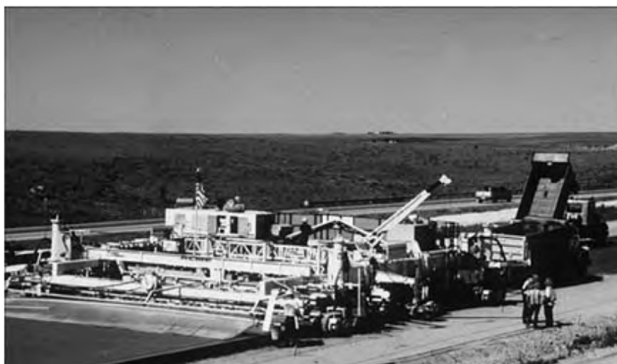
شکل ۳-۲۱- مجموعه تجهیزات اجرای روسازی به روش قالب لغزنده
