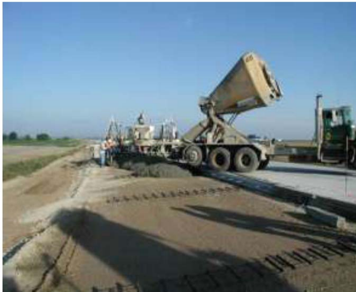
شکل ۳-۱۳- نمونه‌ای از کامیون همزن
