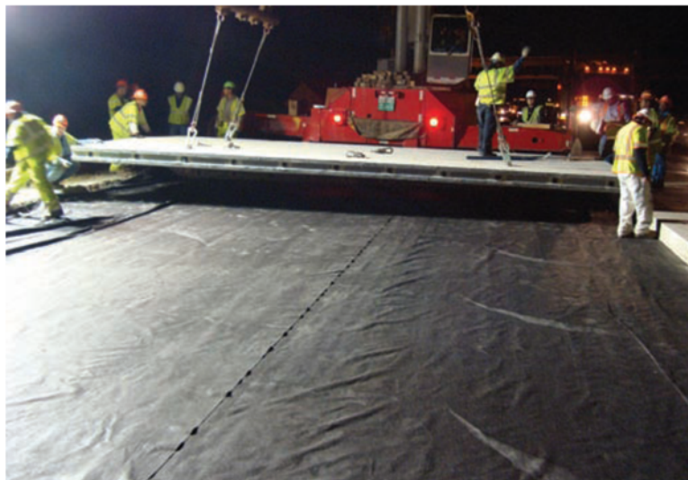
شکل ۱-۱۱- حمل دال پیش‌ساخته و استقرار شب‌هنگام آن در محل روسازی
