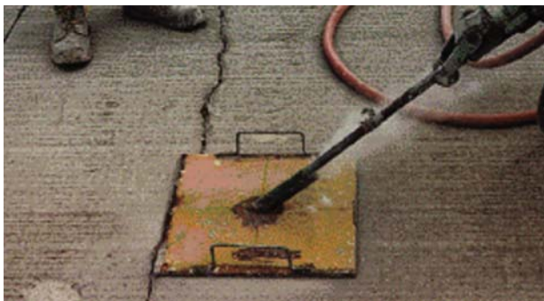
ب- حفر سوراخ در روسازی بتنی با تجهیزات ساده
