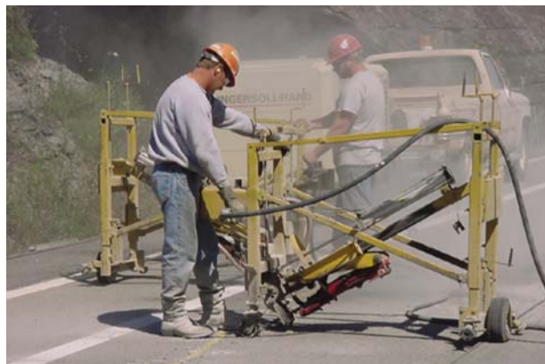
الف- حفر سوراخ در روسازی بتنی با دستگاه مکانیزه
