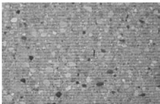
شکل ۴-۳۸- نمایی از سطح روسازی بتنی پس از عملیات سایش
