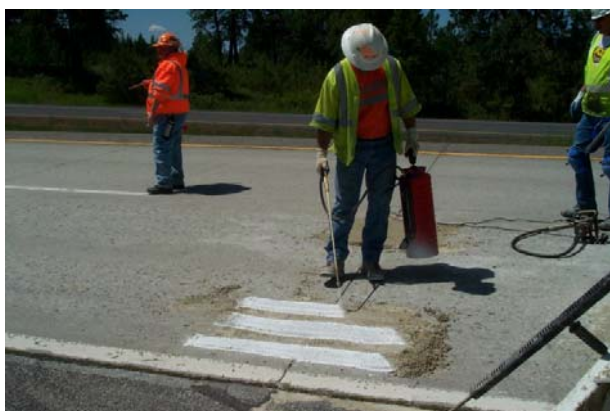
خ- عمل آوری محل شیارهای پر شده
