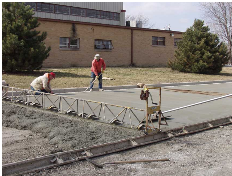
شکل ۳-۳۶- شمشه (ماله) ارتعاشی برای پخش و پرداخت بتن- با کمک قالب ثابت
