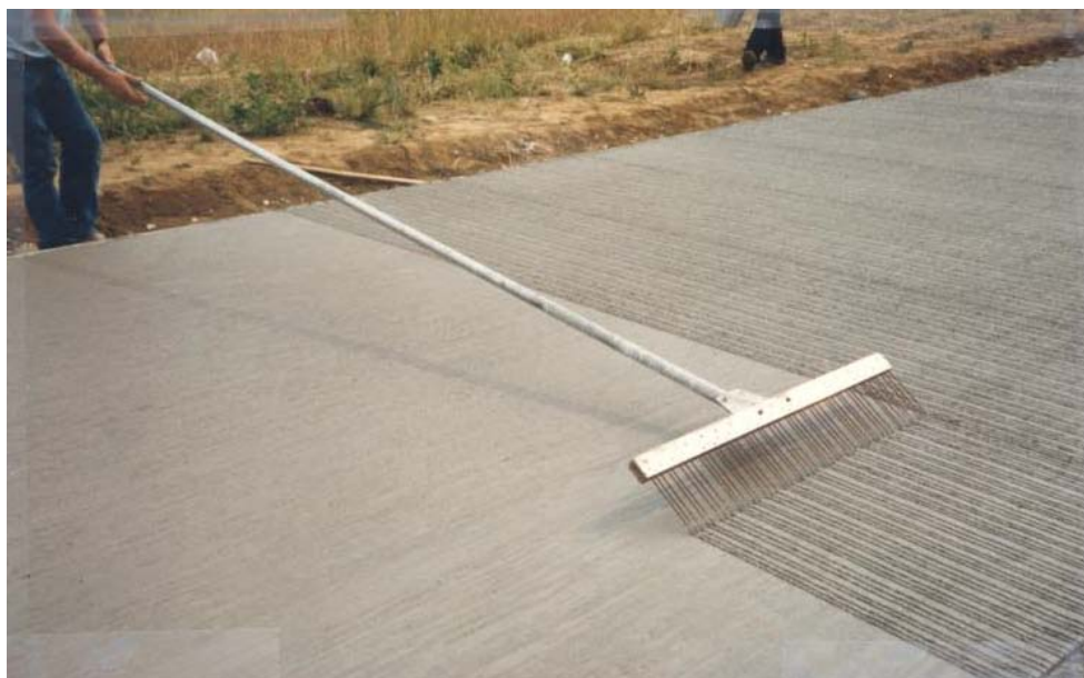
شکل ۳-۴۱- ایجاد بافت درشت (عرضی) در رویه بتنی به روش دستی
