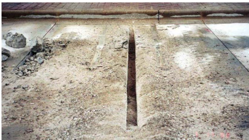
شکل ۴-۲۳- ایجاد برش آزادکننده در محلی که باید بتن برداشته شود
