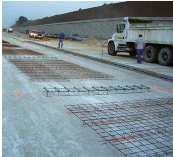
شکل ۱-۸- نصب شبکه‌های فولادی و میلگردهای انتقال بار برای روسازی بتنی مسلح درزدار
