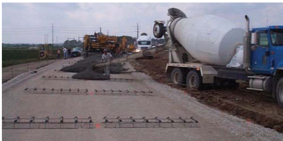
شکل ۳-۱۴- نمونه‌ای از کامیون‌های مخلوط‌کن در حال تخلیه بتن در محل رویه بتنی
