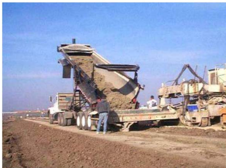
شکل ۳-۱۱- نمونه‌ای از کامیون حمل بتن به همراه محفظه تخلیه
