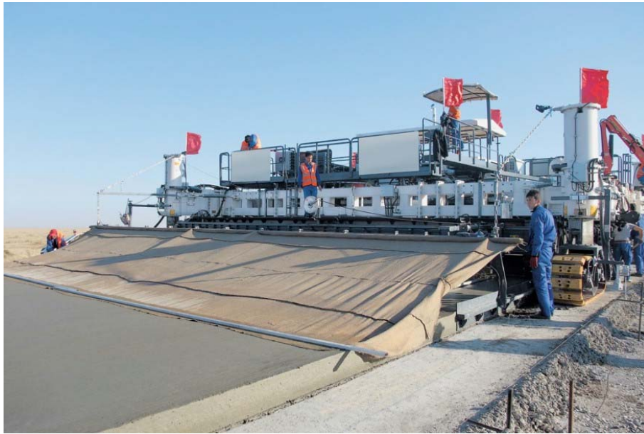
شکل ۳-۳۹- کشیدن گونی روی سطح بتن تازه برای ایجاد بافت ریز
