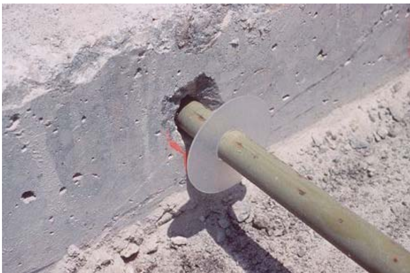
شکل ۴-۲۵- نصب واشر پلاستیکی برای جلوگیری از فرار مواد تزریق شده از محل میلگردهای انتقال بار
