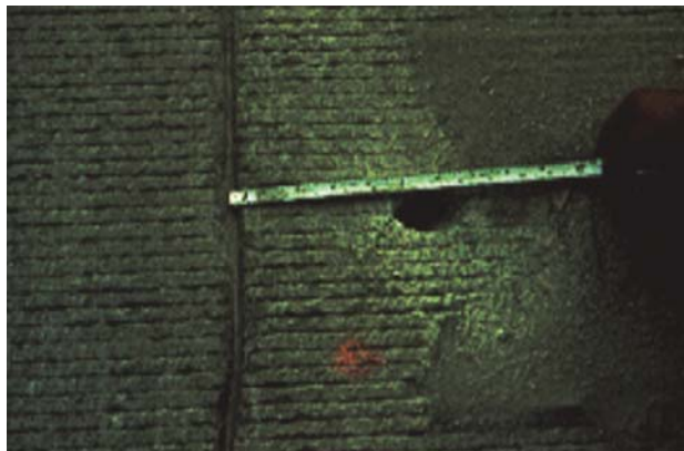
پ- کنترل فاصله سوراخ (پس از حفر سوراخ باید داخل آن با فشار هوا بادگیری شود تا عاری از مواد زائد گردد)
