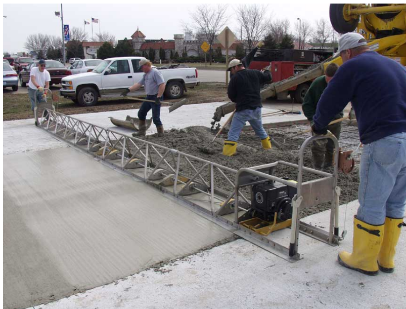
شکل ۳-۳۷- شمشه (ماله) ارتعاشی برای پخش و پرداخت بتن- با کمک رویه بتنی مجاور
