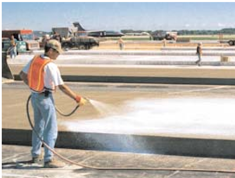
شکل ۳-۴۳- پاشش ماده عمل‌آوری به صورت دستی
