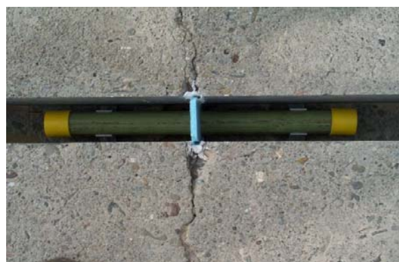
ث- موقعیت میلگرد انتقال بار نسبت به محل ترک
