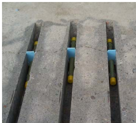
ث- موقعیت میلگرد انتقال بار نسبت به محل ترک
