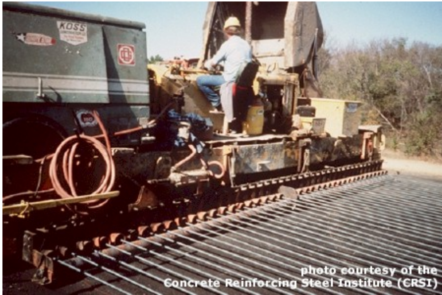
شکل ۳-۱۹- نمونه‌ای از تجهیزات خودکار جای‌گذاری میلگرد طولی در روسازی بتنی مسلح پیوسته
