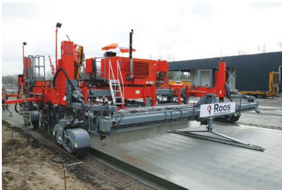
شکل ۳-۳۱- ماله طولی (نوسانی) که در ادامه تجهیزات اجرای رویه بتنی به روش قالب لغزنده قرار گرفته است
