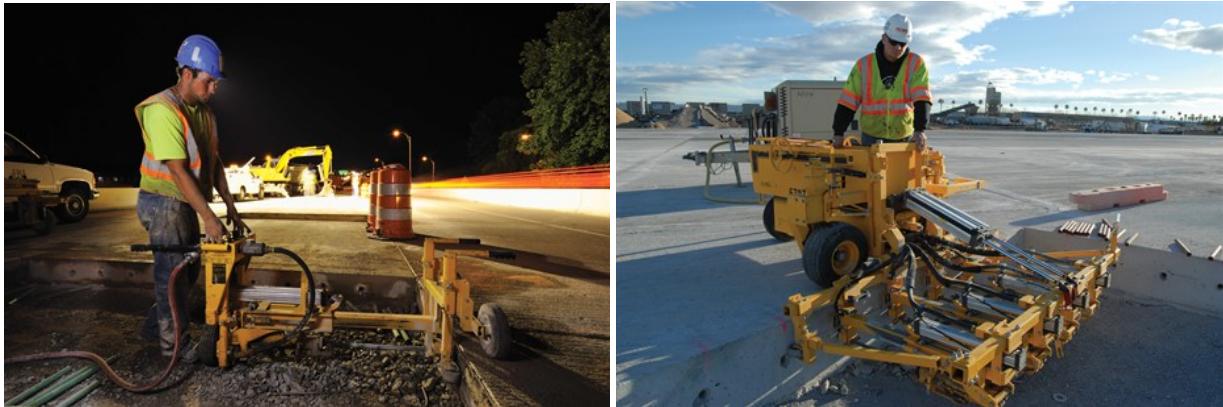
شکل ۴-۲۴- ایجاد سوراخ در محل دیوارهای محل وصله برای نصب میلگردهای انتقال بار
