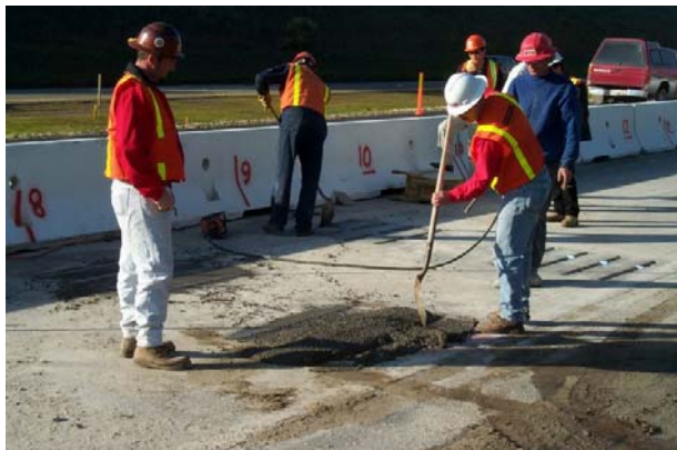
چ- پرکردن محل شیارها
