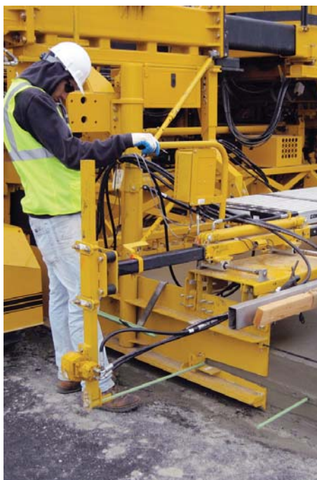
شکل ۳-۱۷- نمونه‌ای از تجهیزات جای گذاری میلگرد دوخت
