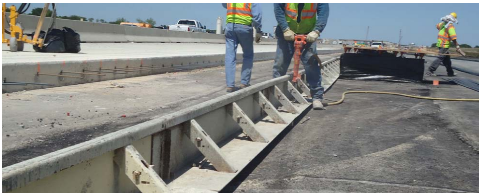
شکل ۳-۲۹- مهار قالب به لایه زیراساس
