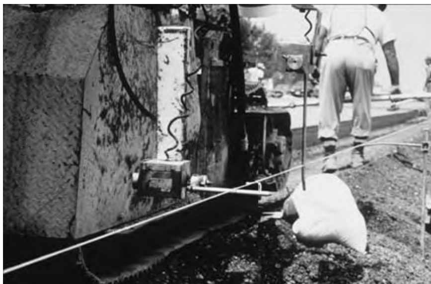
شکل ۳-۲۳- ریسمان راهنما و میله حسگر در دستگاه فینیشر بتن
