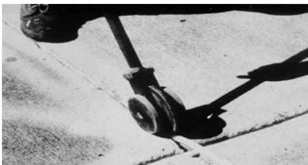
شکل ۳-۴۴- ابزار قرار دادن میله پشت‌بند در محل درز
