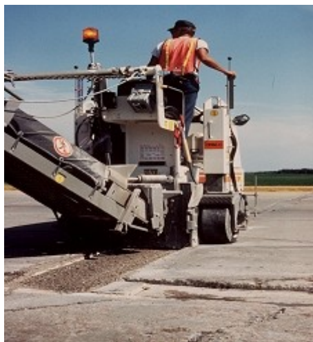
شکل ۴-۱۹- ماشین تراش کاربیدی برای تراش بتن
