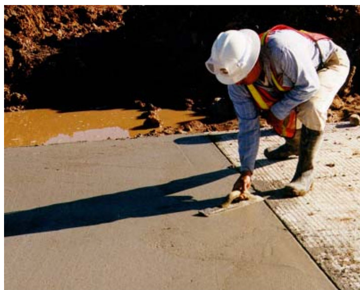
شکل ۳-۳۵- استفاده از ماله دستی برای رفع عیب در نزدیکی لبه دال بتنی
