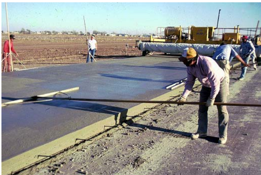
شکل ۳-۳۴- شمشه دستی - هنگام به جلو راندن شمشه، دسته آن پایین قرار می‌گیرد.
