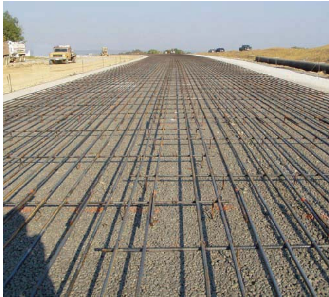
شکل ۱-۱- نصب میلگرد در روسازی بتنی مسلح پیوسته
