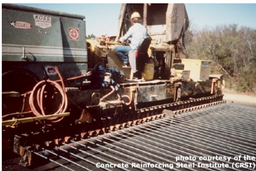
شکل ۳-۵- نصب میلگردهای روسازی بتنی مسلح پیوسته با استفاده از تغذیه کننده لوله‌ای
